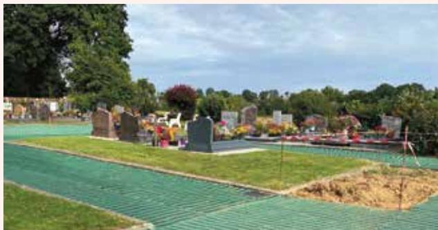
*Pose d'un revêtement "personnes à mobilité réduite" (PMR) par Les services techniques dans le cimetière contemporain. La pelouse va le recouvrir. La pose de bordures en chêne est prévue prochainement pour délimiter les massifs.*
